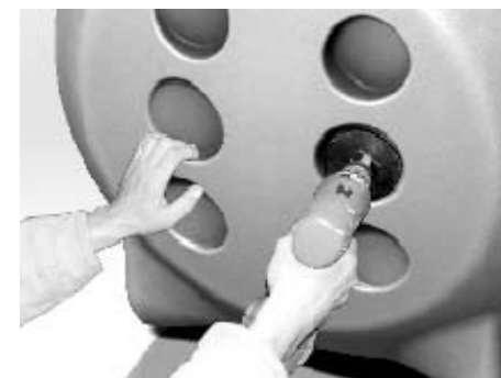
Рис. 3 Сверление отверстия для установки ЗПТ
